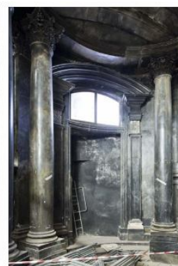
Figura 85 Vista degli intonaci da restaurare nel vestibolo SW.
