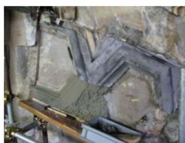
Figura 56 Restituzione del profilo originario con la plastilina.
