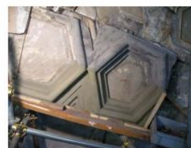
Figura 57 Restituzione del profilo originario con la plastilina.
