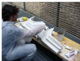
Figura 58 Applicazione di idoneo prodotto distaccante prima della ricollocazione in opera della controforma in gesso.
