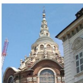
Figura 80 Vista degli intonaci della guglia.
