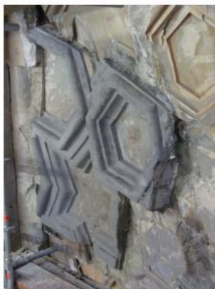
Figura 63 Rimozione della controforma e finitura della superficie.
