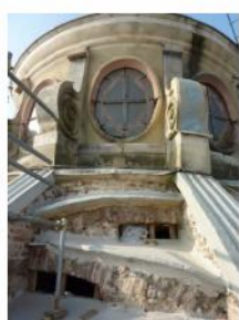
Figura 81 Vista della guglia, dei costoloni, dei voltini laterali, degli sgusci, delle cornici e delle spallette dei vani di alloggiamento dei serramenti del cestello.
