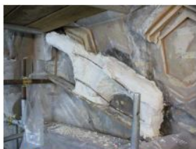
Figura 53 Preparazione della controforma in gesso.
