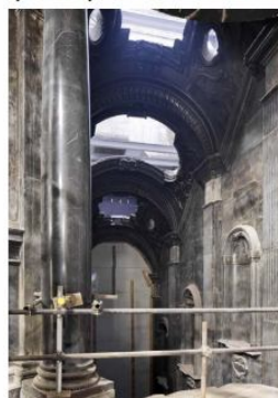
Figura 86 Vista degli intonaci dei capitelli da restaurare nella scalone NW di discesa al Duomo.
