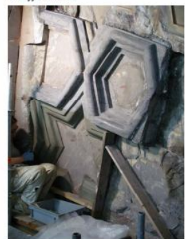
Figura 61 Restituzione del profilo originario del concio a forma di stella con la plastilina.
