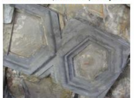
Figura 58 Applicazione di idoneo prodotto distaccante prima della ricollocazione in opera della controforma in gesso.
