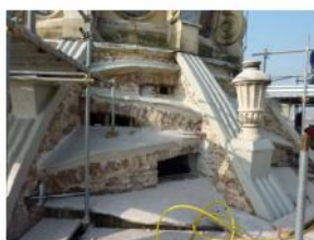
Figura 82 Vista dei costoloni, dei voltini laterali, degli sgusci, delle cornici e delle spallette dei vani di alloggiamento dei serramenti del cestello.
