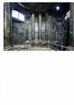
Figura 87 Vista degli intonaci dei capitelli da restaurare nella scalone SW di discesa al Duomo.
