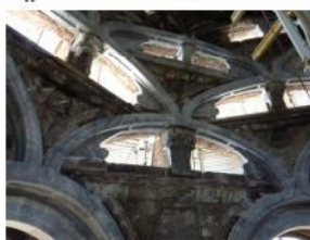
Figura 83 Vista degli intradossi, intonacati a da intonacare, degli archi del cestello.
