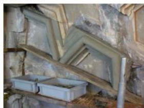
Figura 52 Restituzione del profilo originario con la plastilina.
