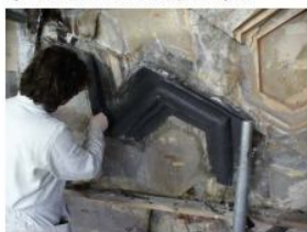
Figura 55 Finitura del concio dopo il collaggio della malta.
