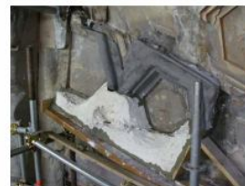
Figura 59 Ricollocazione della controforma prima della fase di collaggio della malta.
