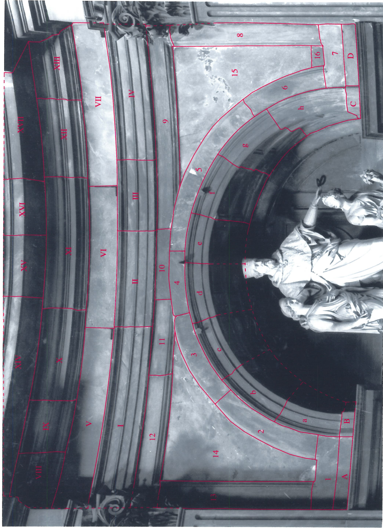
TAV. 41: I LIVELLO - SETTORE NE - ARCO Individuazione dei conci sulla fotografia
