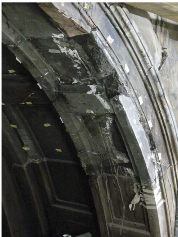
Figura 66 Restituzione del profilo originario con malta a colaggio.
