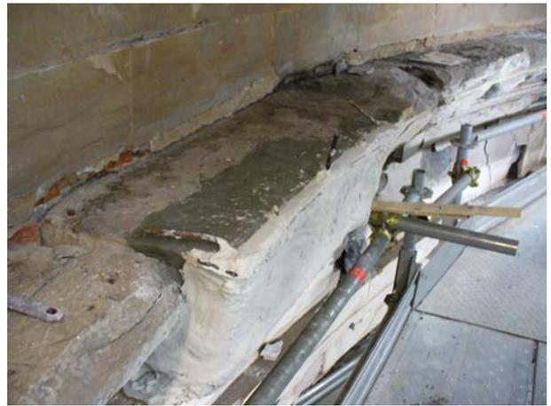
*Figura 41 Preparazione della controforma in gesso.*
