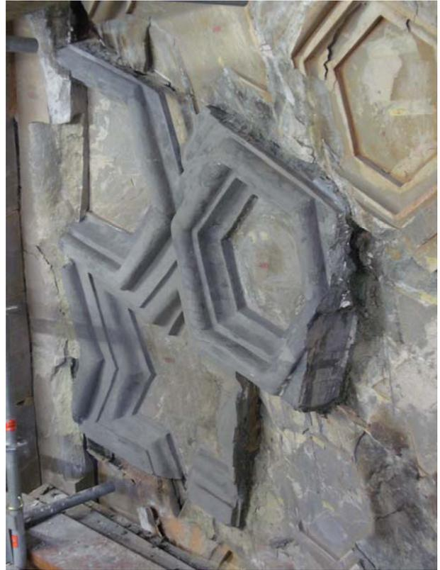
*Figura 63 Rimozione della controforma e finitura della superficie.*
