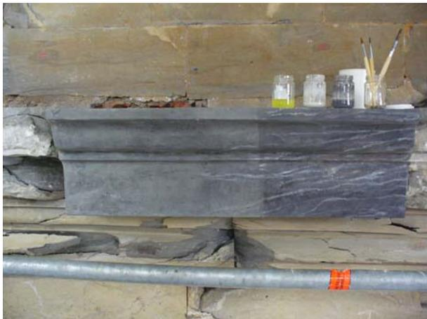
*Figura 48 Trattamento superficiale del concio ricostruito con finalità di equilibratura cromatica e presentazione estetica delle superfici: reintegrazione pittorica del concio con pitture minerali ai silicati.*
