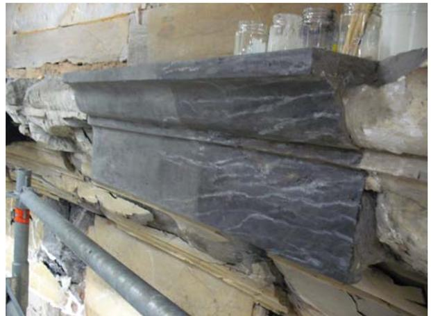
*Figura 49 Trattamento superficiale del concio ricostruito con finalità di equilibratura cromatica e presentazione estetica delle superfici: reintegrazione pittorica del concio con pitture minerali ai silicati.*
