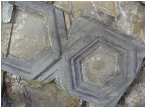
*Figura 60 Rimozione della controforma e finitura della superficie.*
