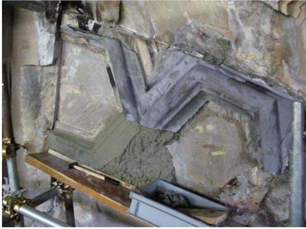
*Figura 56 Restituzione del profilo originario con la plastilina.*
