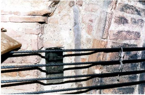
*Figura 23 Particolare della cerchiatura del tamburo*
