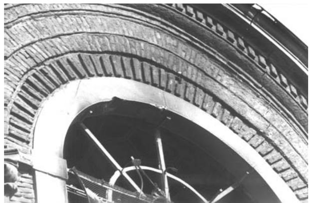
*Figura 21 Particolare di un arco dei finestroni del tamburo all'indomani dell'incendio*
