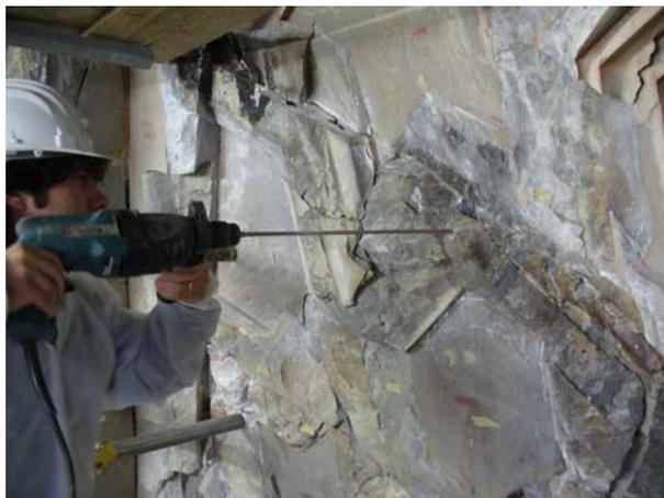
Figura 51 Predisposizione fori per inserimento dell'armatura.
