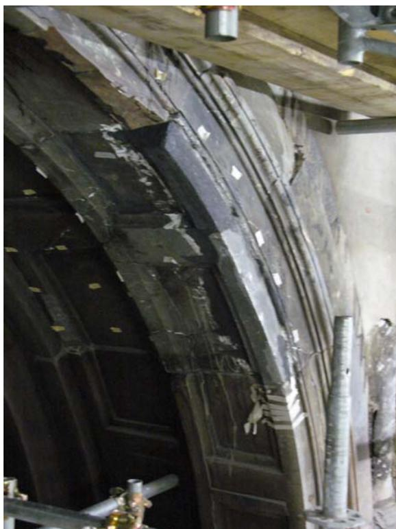
Figura 67 Restituzione del profilo originario con malta tixotropica.
