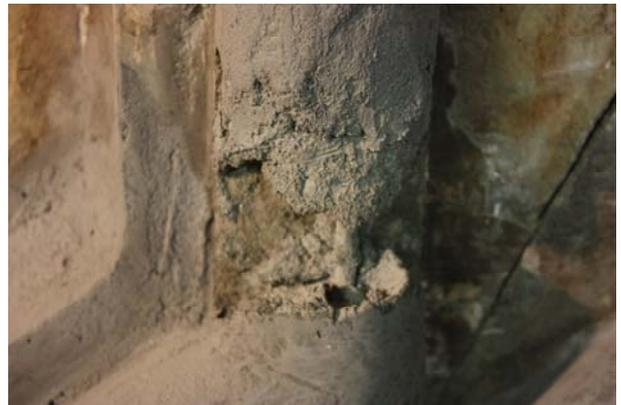
*Figura 77 PUNTI CRITICI DA EVITARE: particolare della mancanza di una porzione del volume integrato dovuta all'interruzione del flusso della malta durante il colaggio, probabilmente a causa del rapprendimento della malta stessa, che ha di conseguenza ostruito il passaggio all'interno della controforma.*
