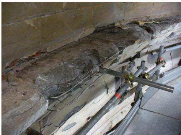
*Figura 38 Predisposizione dell'armatura in acciaio inossidabile di diametro  $\geq 4$  mm.*
