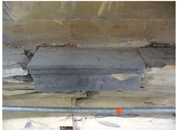
*Figura 47 Rimozione della controforma e rifinitura della superficie per ovviare alle piccole imperfezioni presenti.*
