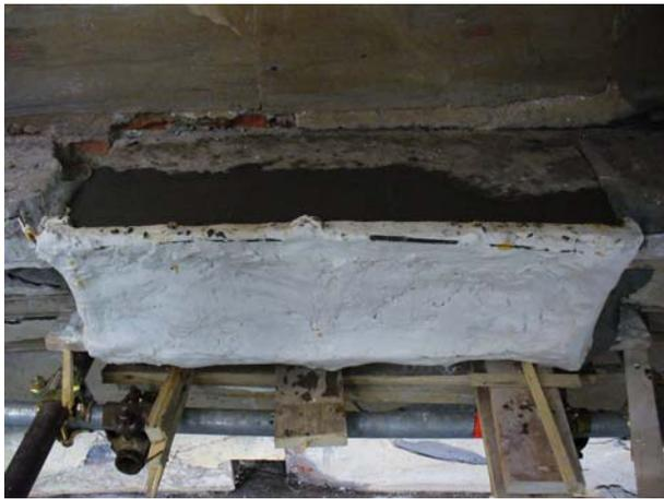
*Figura 46 Ricostruzione del profilo tramite colaggio della malta appositamente formulata.*
