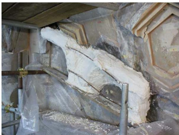
Figura 53 Preparazione della controforma in gesso.
