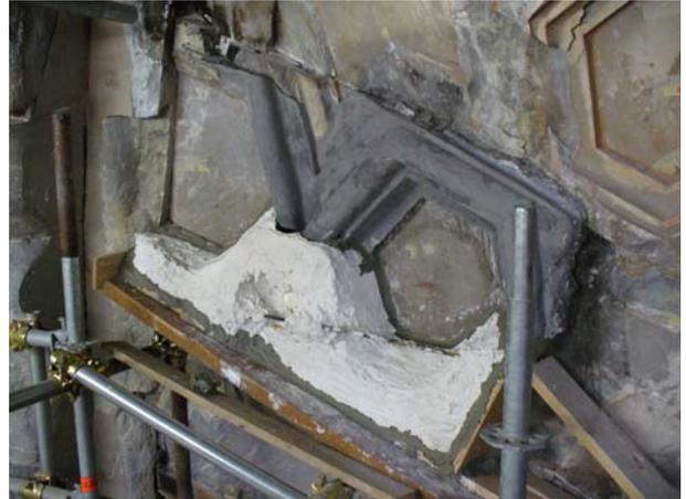
*Figura 59 Ricollocazione della controforma prima della fase di colaggio della malta.*
