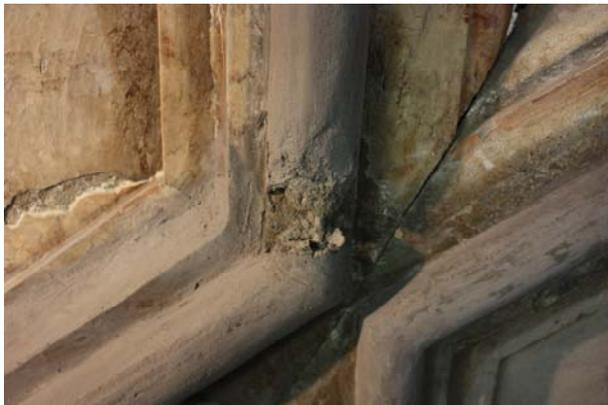
*Figura 76 PUNTI CRITICI DA EVITARE: mancanza di una porzione del volume integrato dovuta all'interruzione del flusso della malta durante il colaggio, probabilmente a causa del rapprendimento della malta stessa, che ha di conseguenza ostruito il passaggio all'interno della controforma.*
