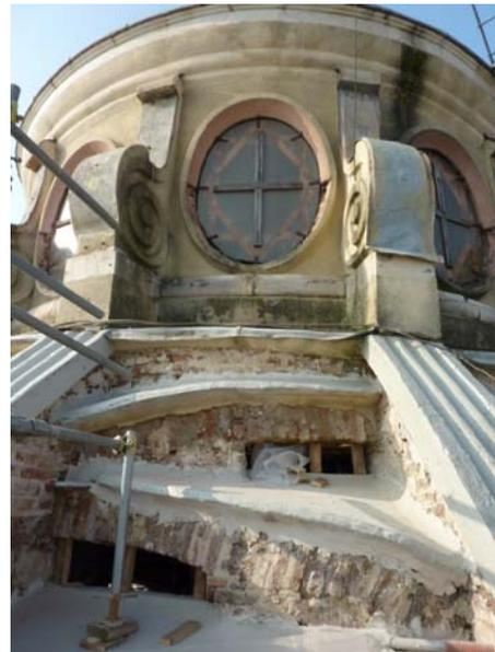
*Figura 81 Vista della guglia, dei costoloni, dei voltini laterizi, degli sguinci, delle cornici e delle spallette dei vani di alloggiamento dei serramenti del cestello.*
