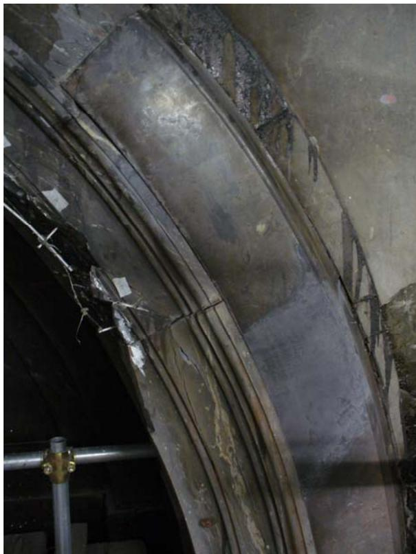
Figura 65 Per l'integrazione volumetrica dei conci sono state sperimentate sia la tecnica con malta a colaggio sia la tecnica con malta tixotropica.
