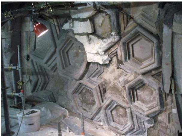
*Figura 74 Rimozione delle controforme in scagliola dopo il colaggio della malta.*
