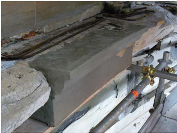
*Figura 40 Ricostruzione del profilo originario con la plastilina.*
