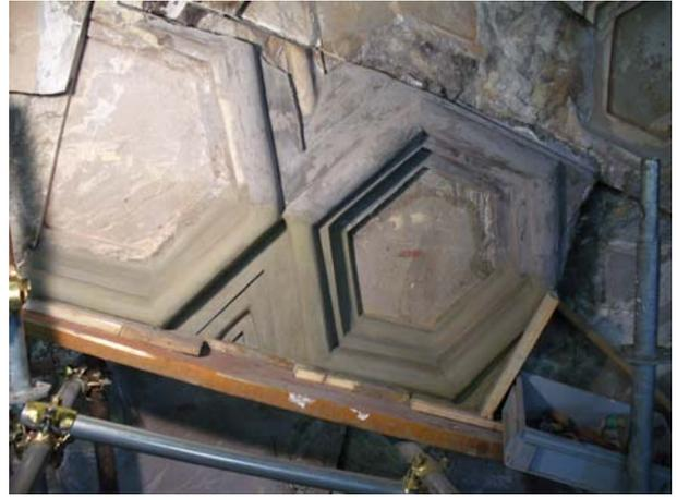
*Figura 57 Restituzione del profilo originario con la plastilina.*
