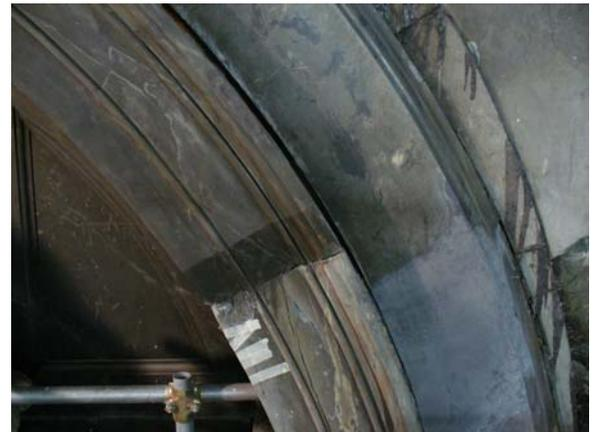
*Figura 69 Concio al termine delle operazioni di integrazione volumetrica e prove di finitura superficiale con cera microcristallina.*
