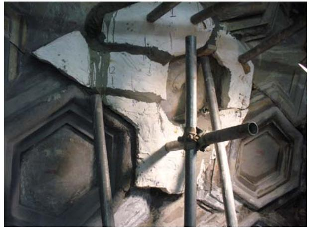
*Figura 73 Ricollocazione delle controforme, sigillatura dei giunti tra i diversi elementi con la plastilina, puntellamento prima di procedere al colaggio della malta.*
