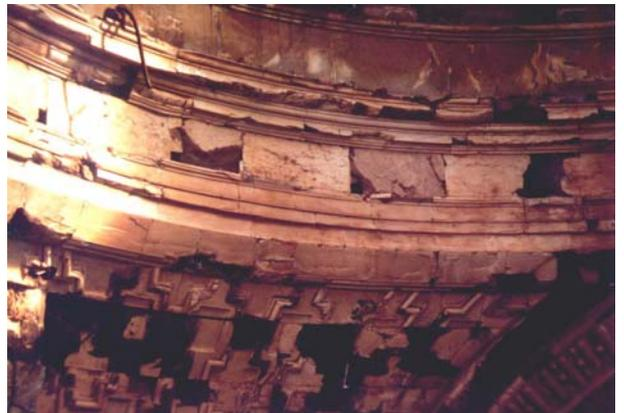
*Figura 7 Trabeazione tra II e III livello dopo l'incendio*
