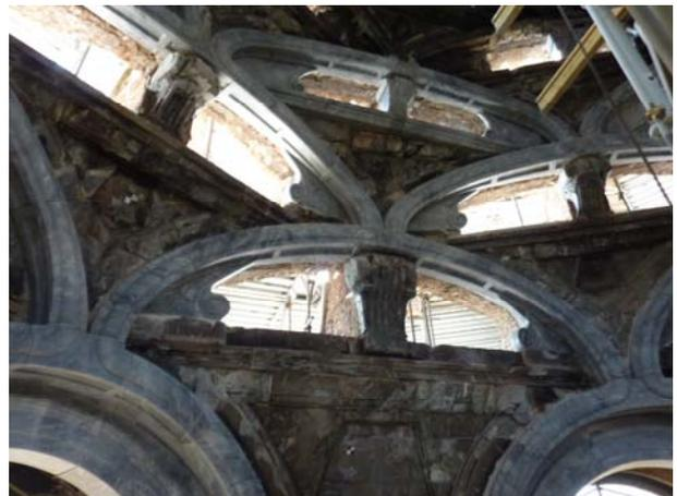
*Figura 83 Vista degli intradossi, intonacati o da intonacare, degli archi del cestello.*
