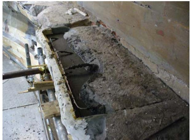
*Figura 45 Ricostruzione del profilo originario tramite colaggio della malta, prestando la massima attenzione alla distribuzione omogenea del materiale all'interno della controforma.*
