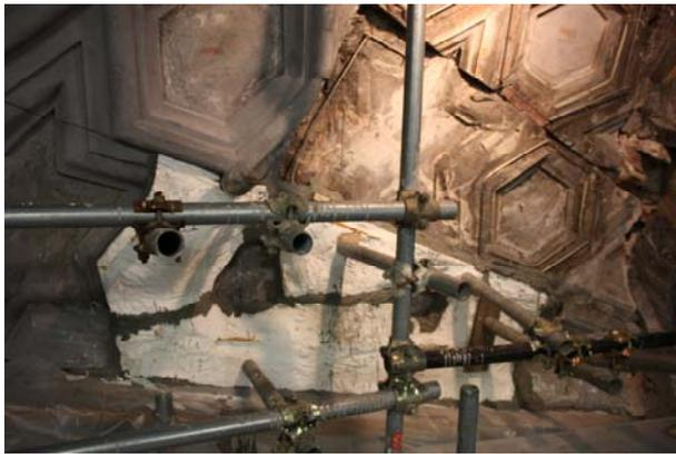
*Figura 72 Ricollocazione delle controforme e predisposizione dei puntelli di sostegno prima di eseguire il colaggio della malta.*
