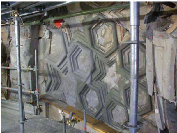
*Figura 70 Ricostruzione volumetrica realizzata con plastilina modellata in situ in aderenza al supporto lapideo.*
