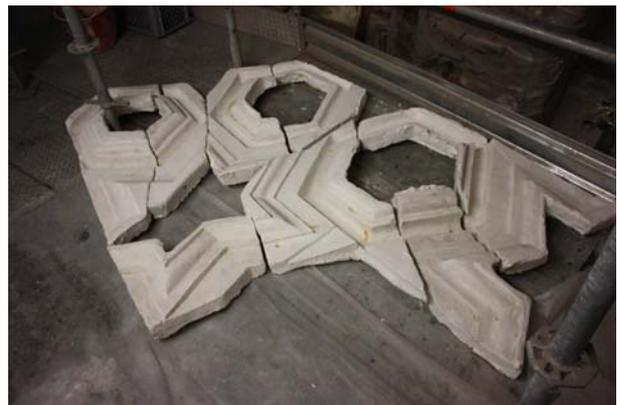
*Figura 71 Controforme in scagliola realizzate direttamente sulla superficie reintegrata con la plastilina.*
