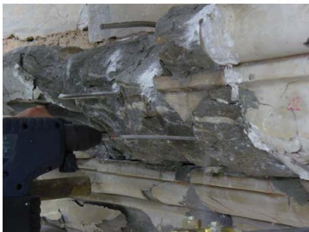
*Figura 37 Predisposizione dei fori per inserimento dell'armatura.*
