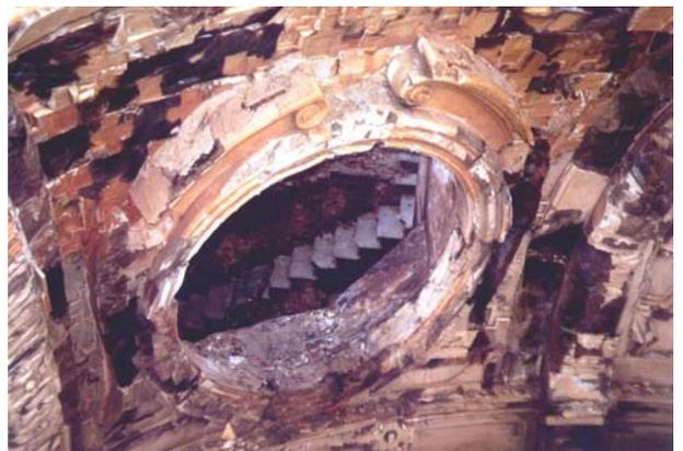
*Figura 9 Particolare di un occhio del bacino tronco dopo l'incendio*
