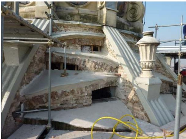
*Figura 82 Vista dei costoloni, dei voltini laterizi, degli sguinci, delle cornici e delle spallette dei vani di alloggiamento dei serramenti del cestello.*
