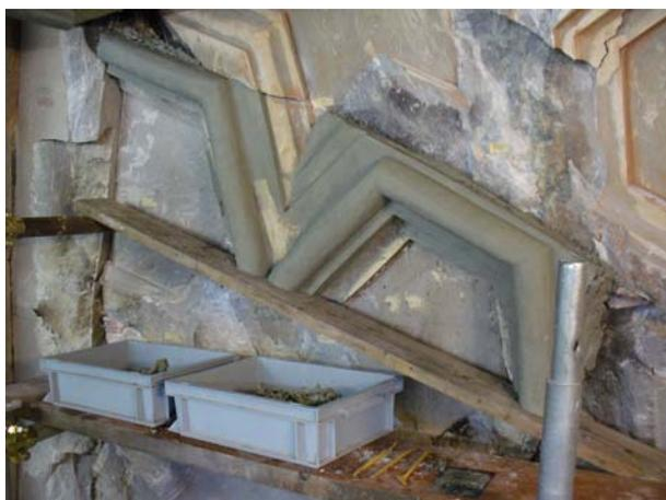
Figura 52 Restituzione del profilo originario con la plastilina.
