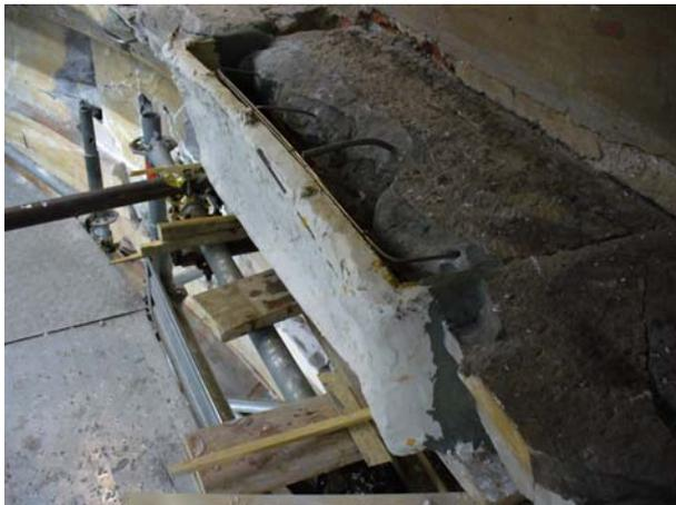
*Figura 44 Dopo l'applicazione di apposito distaccante, la controforma è stata ricollocata in opera in perfetta posizione facendo ricorso a guide e riferimenti appositamente predisposti.*
