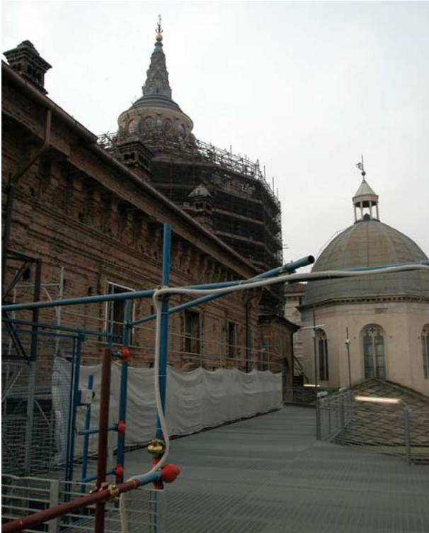
*Figura 28 Particolare del grigliato di accesso alla Cappella a quota +20,50 metri.*
