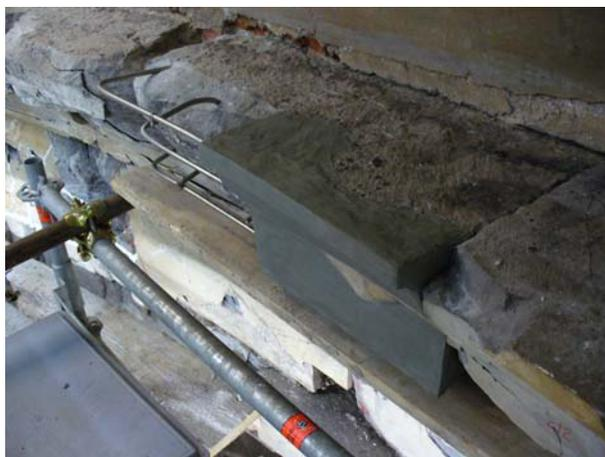
*Figura 39 Ricostruzione del profilo originario con la plastilina.*
